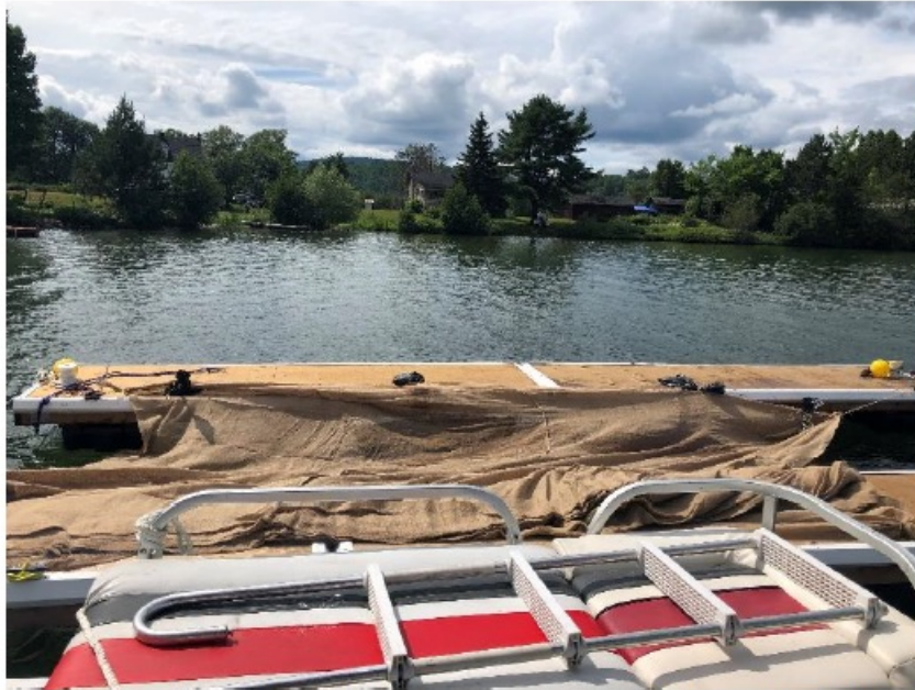
Figure 3. Installation de la toile de jute avec deux quais (photo : Anaëlle Varlet).
